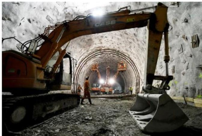
► **PARTIE 3B** : creusement en méthode traditionnelle d'une galerie de 1,3 km sur le tracé du tunnel de base.
