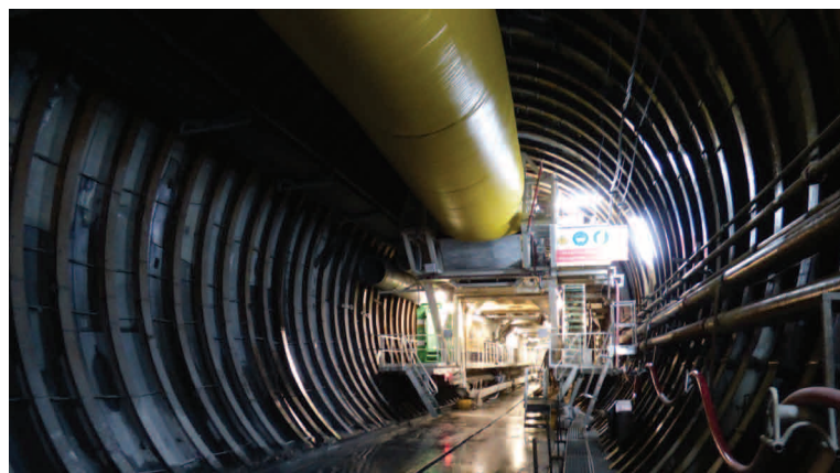
Renforcement du soutènement par cintres HEB ▲
