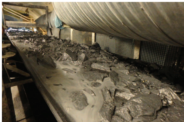
Matériaux excavés lors de l'accident géologique ▲
