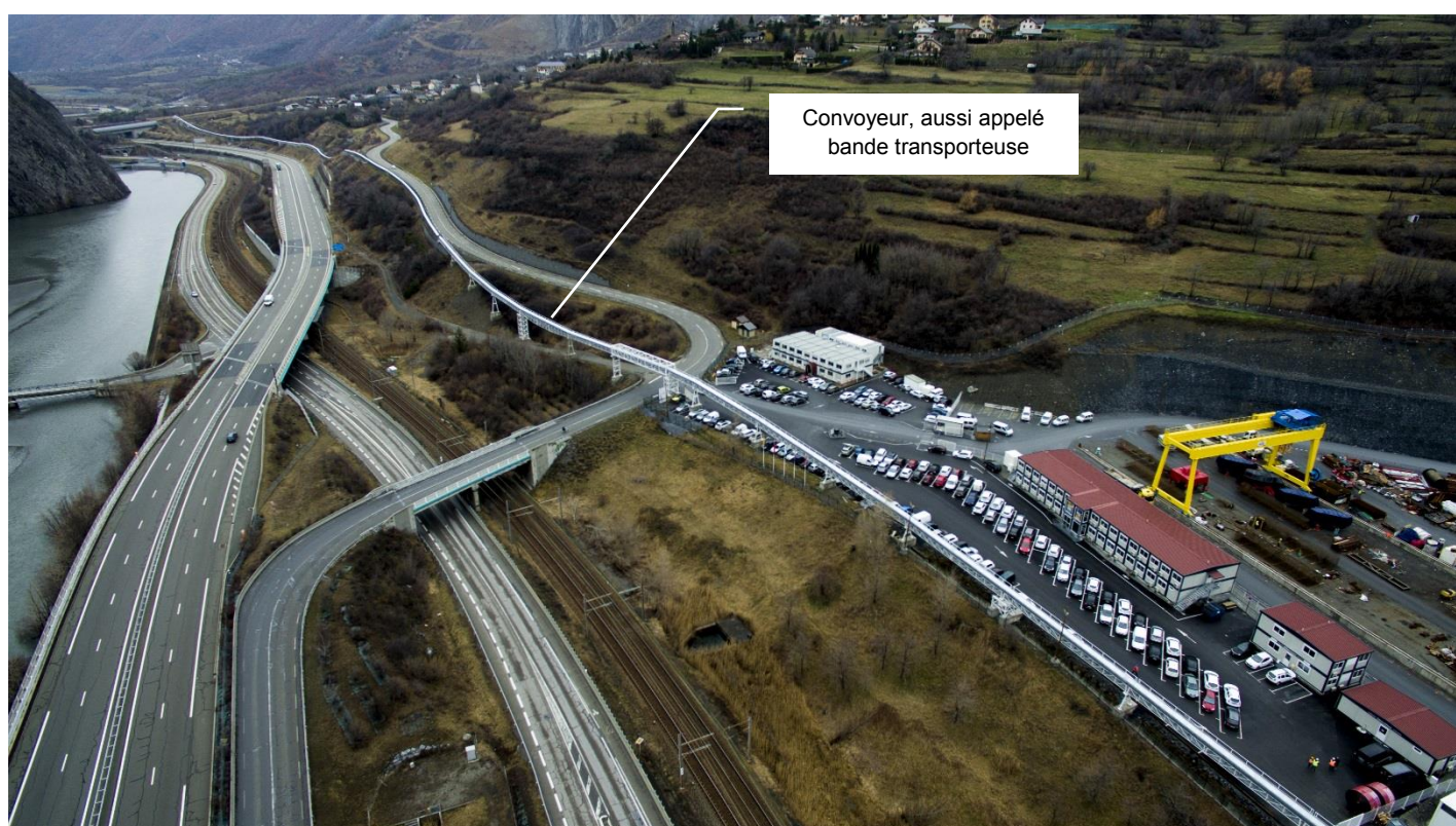
Convoyeur du chantier SMP4 qui achemine les déblais du tunnelier jusqu'au site de dépôt appelé « Saint-Félix ». Crédit photo : Groupement SMP4
