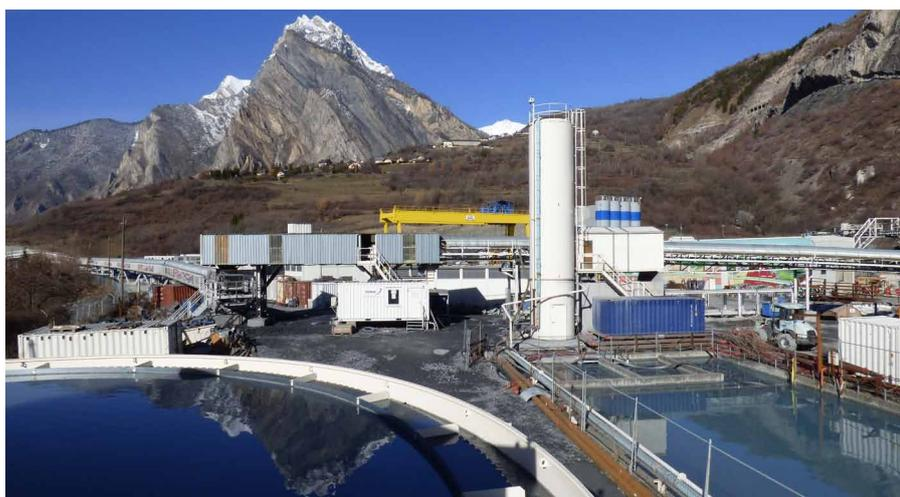
Le nouveau décanteur de 18 m de diamètre
